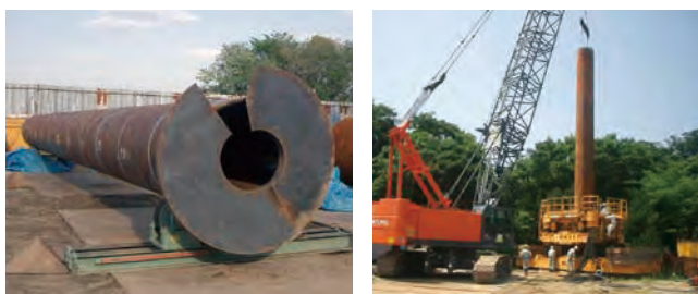
つばさ杭®の先端翼と施工状況
